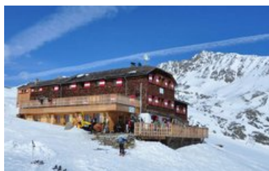
Vernaghütte, 2768 m - Vent
